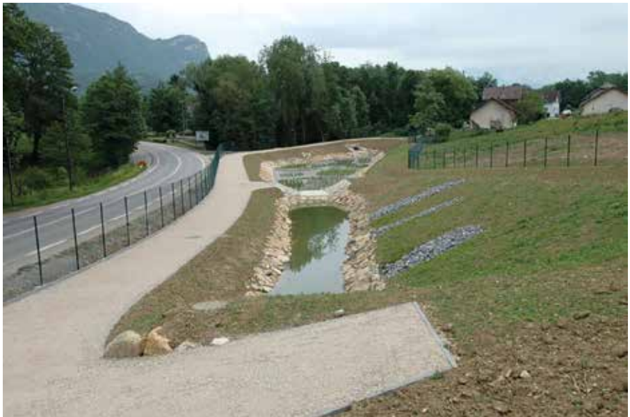
Photo 2 – Bassin de stockage des eaux de pluies, ZAC des Drouilles à Challes-les-Eaux (© Chambéry métropole)
