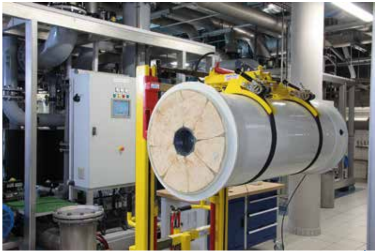
Photo 3 – Rétention des matières en suspension par séparation membranaire (© J.-M. Favre – C2A)
