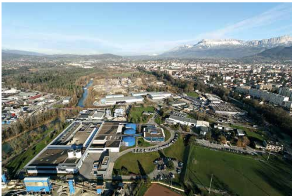
Photo 1 – L'usine de dépollution des eaux usées Siloé située près d'Annecy (© J. Desbiolles)
