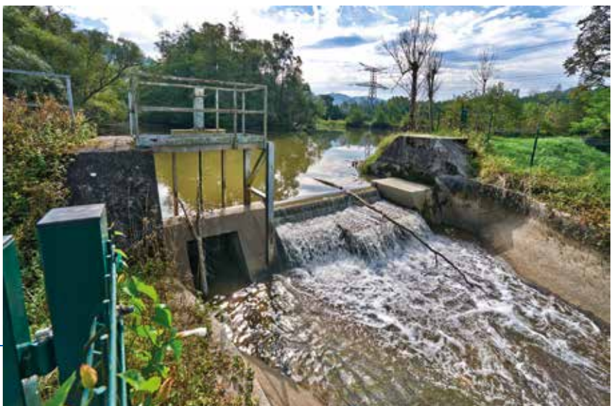
Photo 1 – Aménagement hydroélectrique EDF de la Bridoire (© D. Guillaudin)
