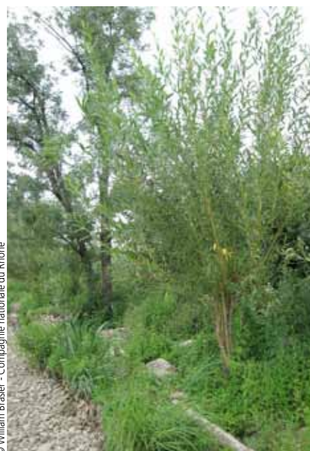
Développement de la végétation implantée et retour d'une diversité au niveau des strates végétales : fascine d'hélophytes au premier plan et fagots de saules arbustifs au second plan. Printemps 2009
