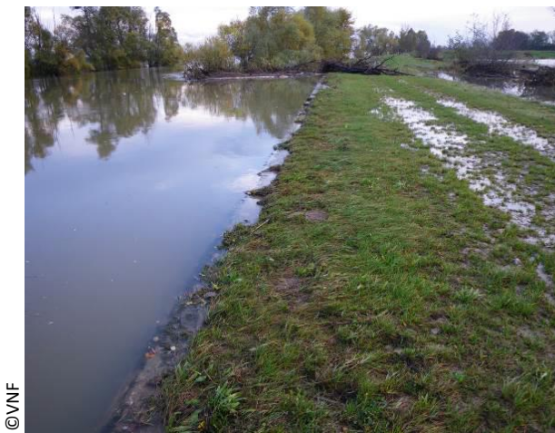
Figure 2. Digue avant travaux
