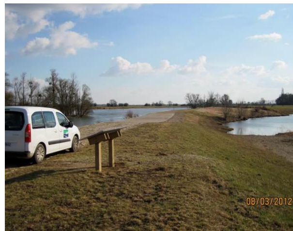
Figure 3 Digue après travaux
