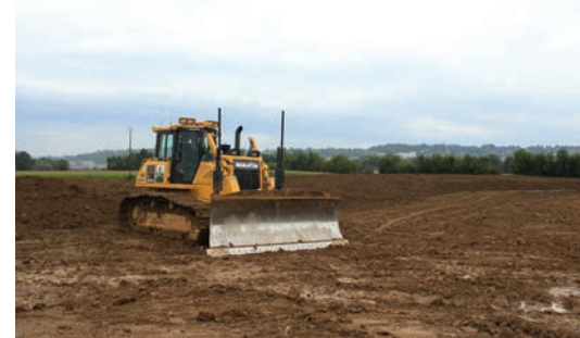
2 Création d'une dépression par terrassement
