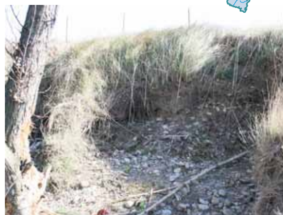
Apparition d'encoches d'érosion au niveau des berges. Mars 2008
