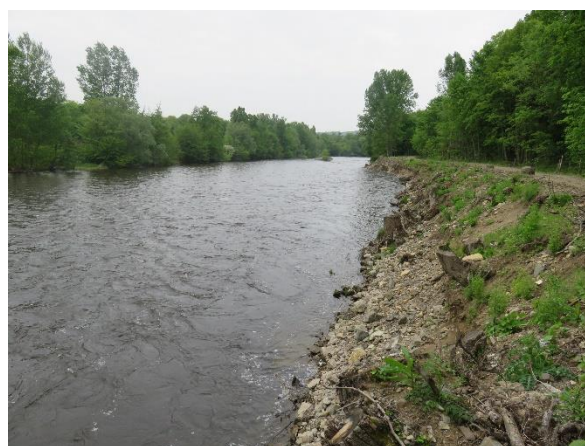
Figure 4. La berge huit mois après travaux (©CEN Auvergne-J.SAILLARD)
