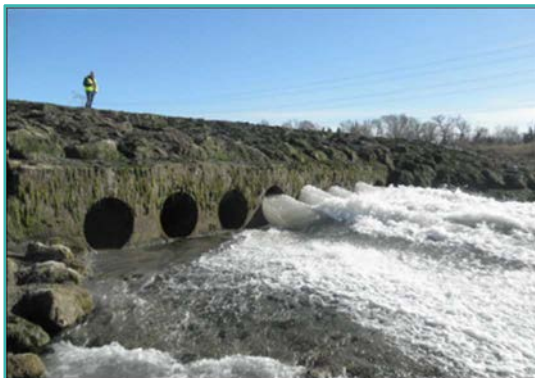
Vue de l'aval après ouverture des premières vannes
