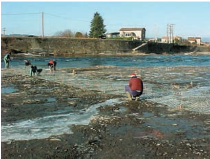
Installation des épis en matelas Réno en 2002.
