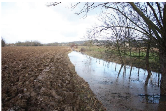
Etat de la frayère en 2012, avant travaux : l'eau est contenue dans un fossé de la parcelle labourée
