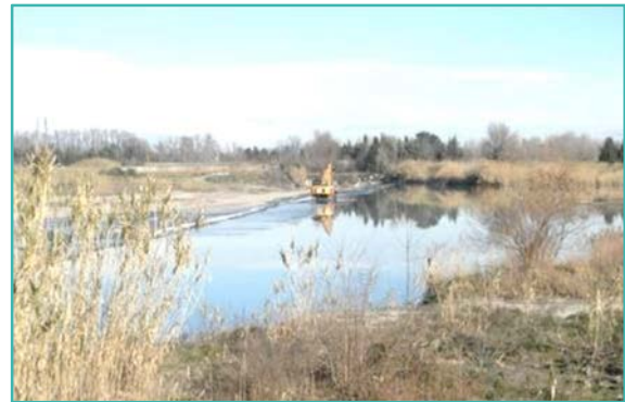
Vue de l'amont avant vidange
