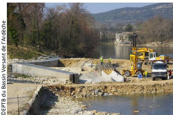
Figure 3. Travaux pour l'installation d'une glissière à canoë
