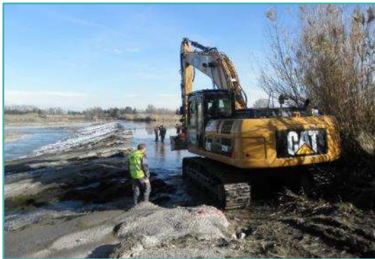
Amené d'une pelle mécanique
