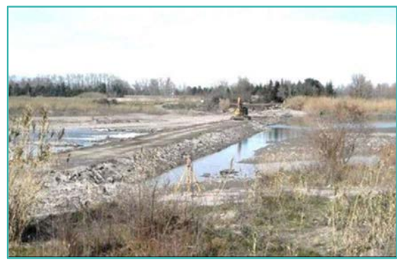
Vue de l'amont vidange en cours
