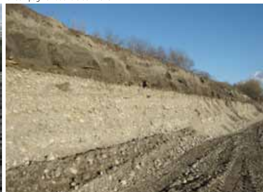
Talutage vertical sur le site de Petite Île, la stratification de talus est bien visible (toit des graviers).
