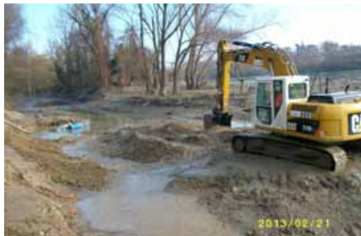
Terrassement du bouchon aval de la lône de la Sainte. Février 2013
