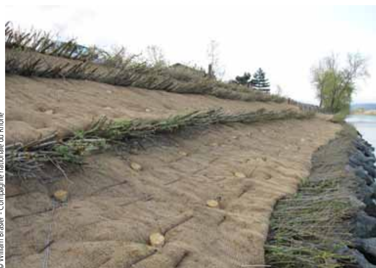
Mise en place de protections de berges en génie végétal sur les berges. Printemps 2009
