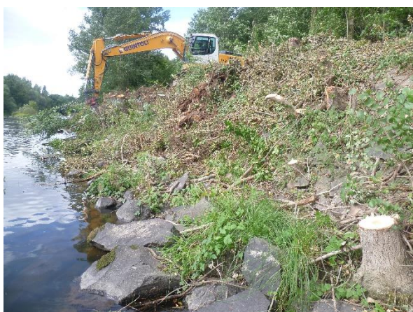
Figure 3. Photographie pendant travaux (©CEN Auvergne-J.SAILLARD)
