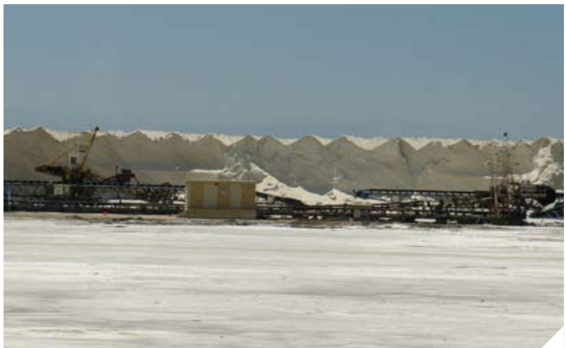
Stockage du sel dans le delta du Rhône (© P. Gaydou).
