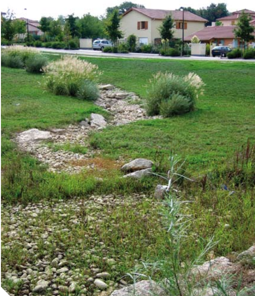
Noue ou fossé d'infiltration intégré aux espaces verts d'une zone pavillonnaire à l'Isle d'Abeau – 38 (© GRAIE)
