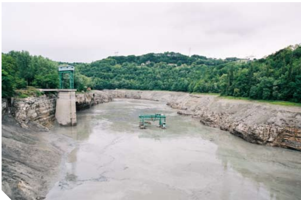
La retenue de Génissiat dont le niveau est abaissé pour faciliter la chasse aux sédiments (ici à l'amont du barrage) (© Photothèque CNR).
