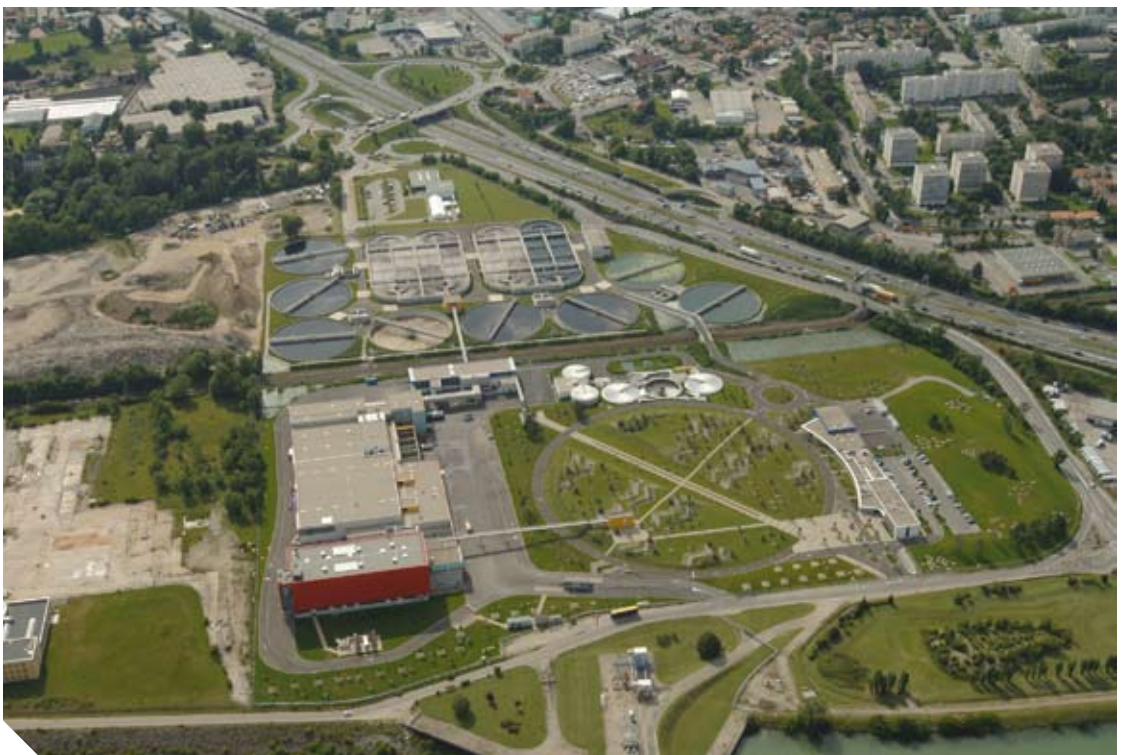
Station d'épuration de Pierre-Bénite (© Le Grand Lyon/J. Léone)
