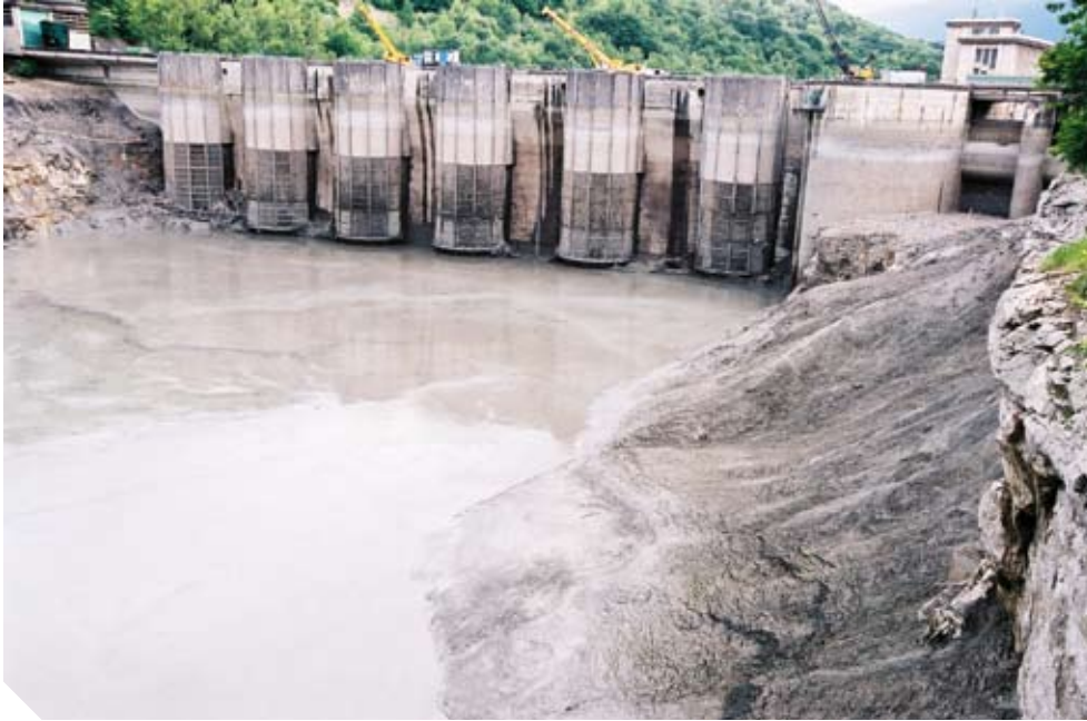
Le barrage de Génissiat (vue sur les prises d'eau amont) pendant une chasse (© Photothèque CNR).
