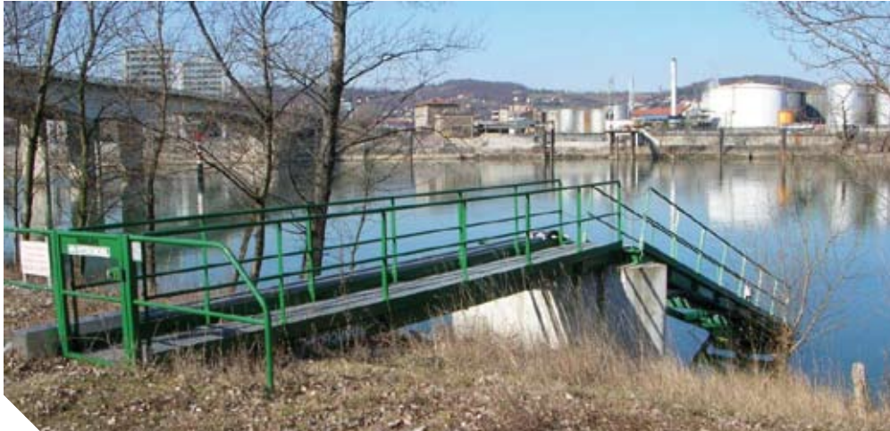
Bras préleveur des eaux du Rhône à la station d'alerte et de suivi de Ternay (© Burgeap - G. Boudin 2005)
