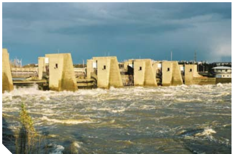
Le barrage de Pierre-Bénite lors d'une crue (© G. Poussard)
