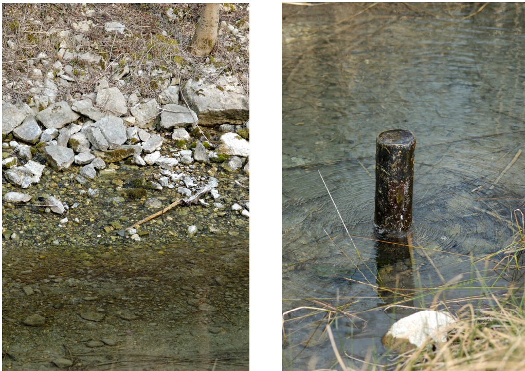
Figure 66. Photo 1, à gauche : les écoulements de la terrasse vers le canal, dans celui-ci les galets sans vase soulignent les arrivées d'eau par le fond du canal (sauf si ce canal est régulièrement curé). Photo 2, à droite : Tube de décharge avec eau jaillissante du canal de Rossillon. Les deux photos sont positionnées sur la carte de la figure 65.
