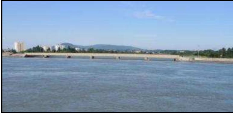
Vue du canal de dérivation et de la confluence avec le Roubion sous le pont
