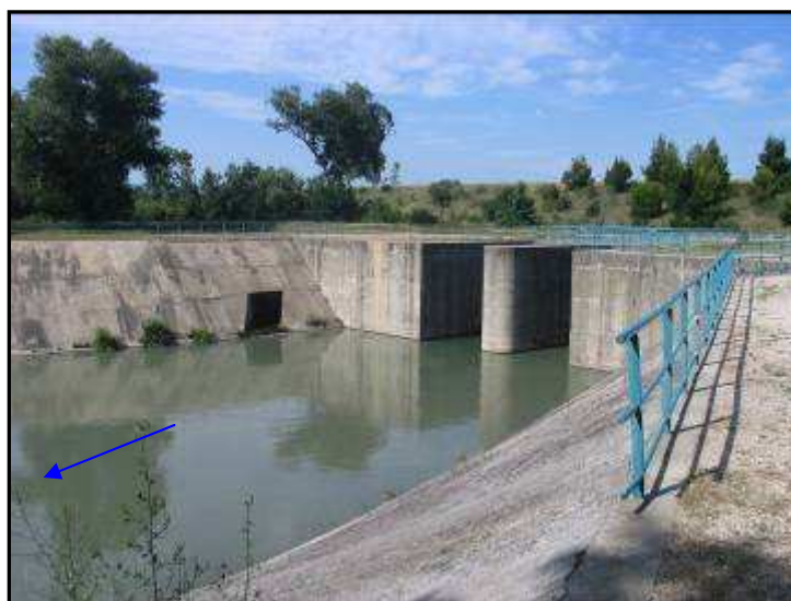
Vue des aménagements sur le Roubion
