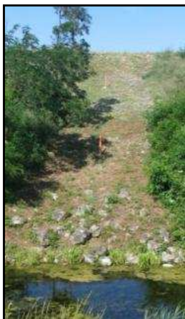
Vue des piézomètres
