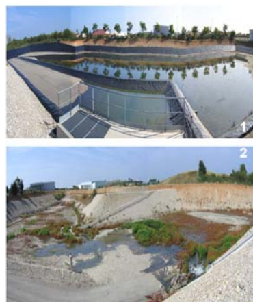
Figure 2. Bassin de rétention (1) et Bassin d'infiltration (2) du site Django Reinhardt.
