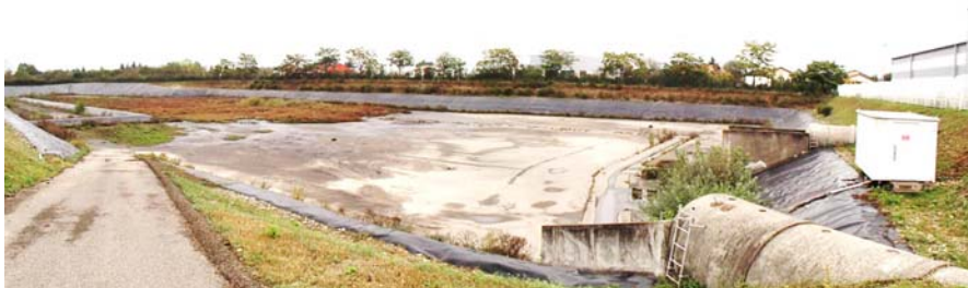
Figure 6. Bassin de retenue-décantation Django-Reinhardt
