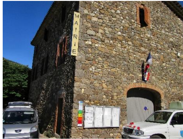
FIG. 3.33 — DERNIER MODÈLE DE L'ÉCHELLE GRAVISEC PLACÉ SUR LE MUR DE LA MAIRIE DE MIALET À CÔTÉ DES PANNEAUX D'INFORMATION À LA POPULATION
