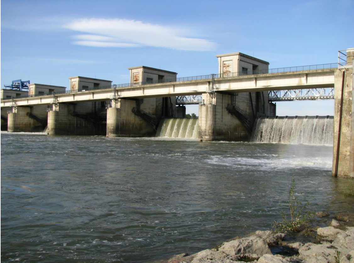
Barrage à Donzère (26). Le débit qui s'écoule à l'aval fixe la côte de la ligne d'eau dans le vieux Rhône, laquelle influence à son tour le niveau de la nappe alluviale (© F. Paran)
