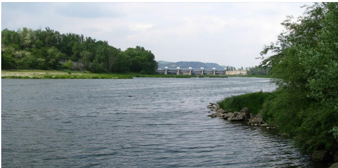
Barrage CNR sur le Rhône à proximité de Beauchastel (84) (© F. Paran)
