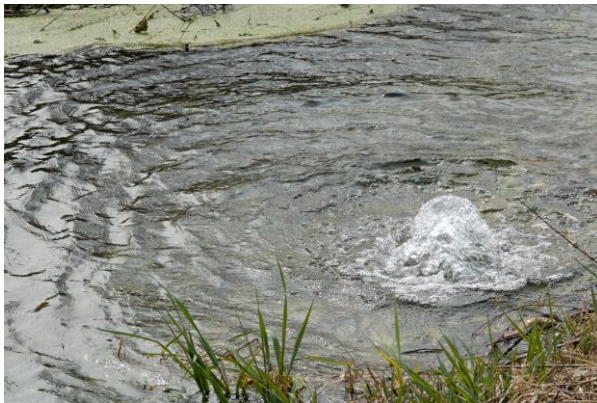
Drain vertical ou piézomètre de décharge d'une nappe en charge dans un contre-canal à Brégnier-Cordon (01) (© F. Paran)
