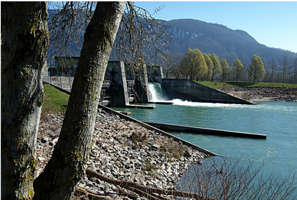
Barrage CNR sur le Rhône à proximité de Brégnier-Cordon (01) (© F. Paran)
