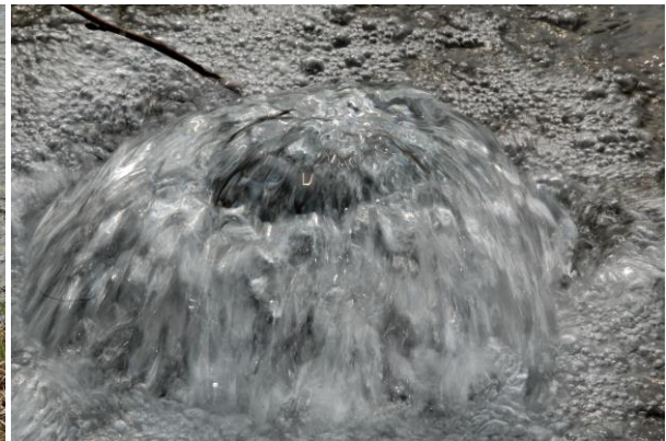
Drain vertical ou piézomètre de décharge d'une nappe en charge dans un contre-canal à Brégnier-Cordon (01) (© F. Paran)
