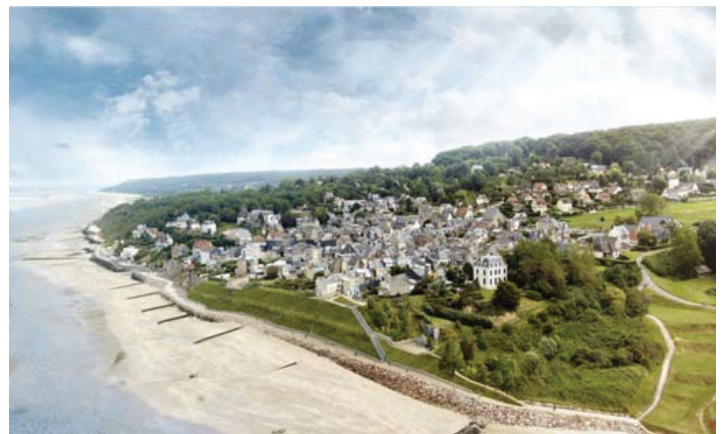
Intégration urbaine d'un ouvrage de confortement de falaise, Villerville (14) Asylum, 2012
