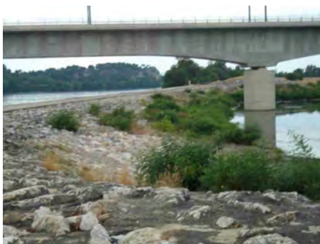
Déversoir sur digue de Caderousse
